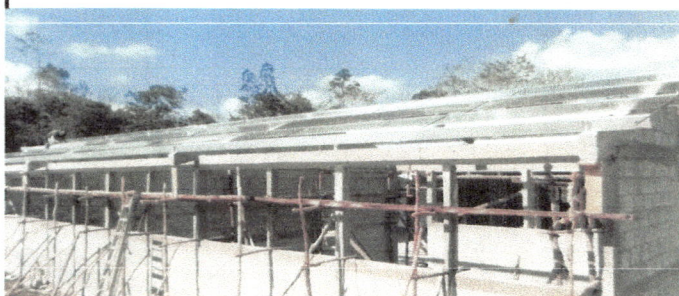
FOTO 1 ESTRUCTURA DE TECHO DE ATRÁS DEL AULA
