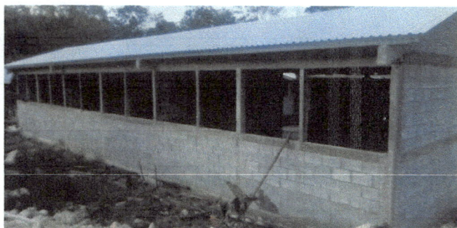
foto 3, se logró la construcción de tres aulas es de atrás de las aulas.
